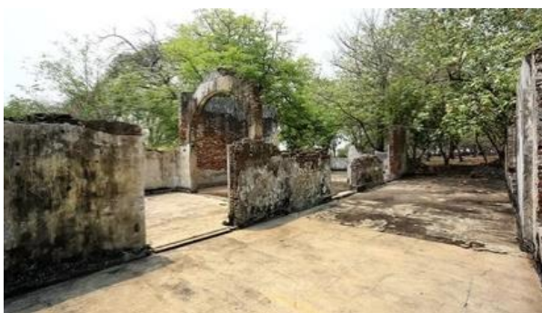
Gambar 4. Sisa bangunan rumah sakit
