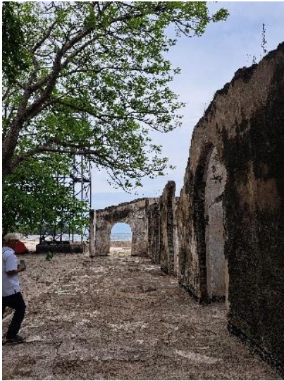
Gambar 4. Sisa bangunan karantina haji Pulau Cipir
