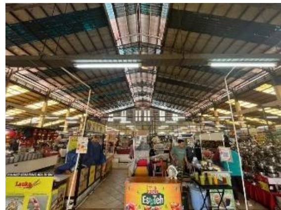
Gambar 5. Skylight pada area pasar
