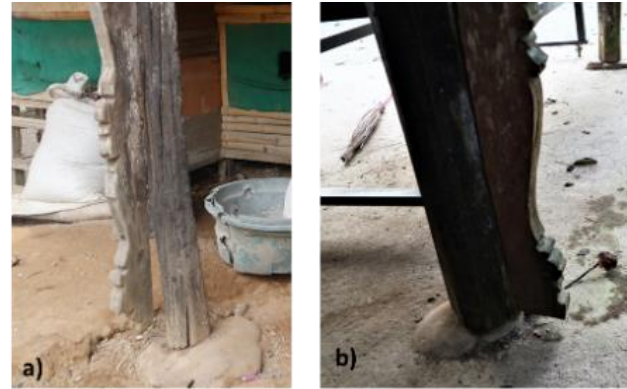
Gambar 6. Pondasi batu alam tak beraturan, Lokasi a) Pulau Bodi, Koto Bangkinang Sebrang, b) Pulau Belimbing, Koto Kuok.
