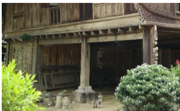
Gambar 8. Pondasi umpak berbentuk geometris, tiang segi empat, dan sambungan lubang purus tiang dengan gelegar . Lokasi Sipungguk, Koto Salo
