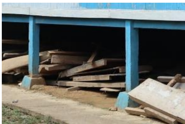
Gambar 11. Pondasi umpak, tiang kayu, dan hubungan tiang dengan balok lantai yang ditumpangkan begitu saja pada Rumah Limas dengan panggung rendah. Lokasi Simpang Kubu, Koto Air tiris
