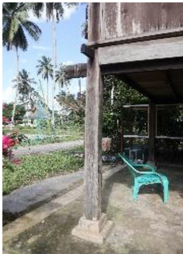
Gambar 9. Pondasi umpak dari semen berbentuk geometris dan tiang kayu berbentuk segi empat pada rumah Limas dengan panggung tinggi. Lokasi Pulau Terap, Koto Kuok
