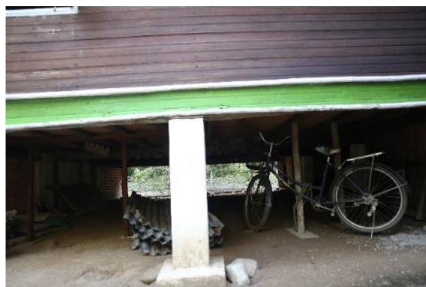
Gambar 12. Pondasi umpak, tiang batu, dan balok lantai yang ditumpangkan di atas tiang pada Rumah Limas dengan panggung rendah. Lokasi Sipungguk, Koto Salo
