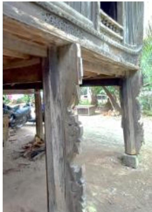
Gambar 7. Tiang berbentuk segi delapan yang menerus ke puncak atap tanpa sambungan di gelagar . Lokasi Teratak Sipungguk, Koto Salo.
