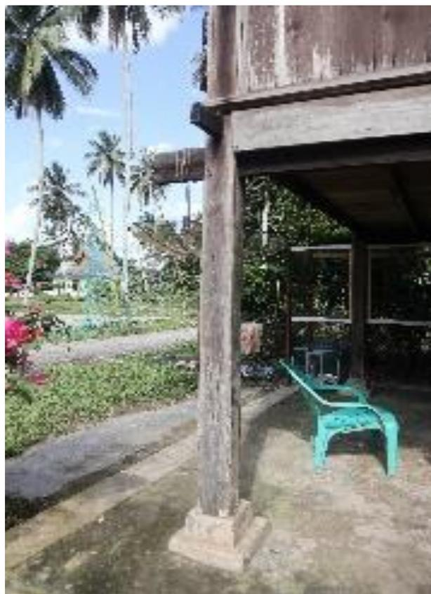
**Gambar 9.** Pondasi umpak dari semen berbentuk geometris dan tiang kayu berbentuk segi empat pada rumah Limas dengan panggung tinggi. Lokasi Pulau Terap, Koto Kuok
