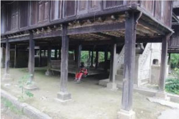
**Gambar 10.** Pondasi umpak yang terbuat dari semen berbentuk geometris, tiang kayu berbentuk segi empat dan sambungan tiang dengan balok lantai Rumah Limas dengan panggung tinggi. Lokasi Naumbai, Koto Air Tiris
