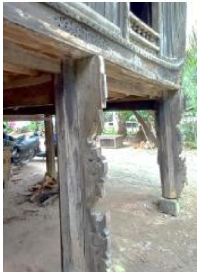
**Gambar 7.** Tiang berbentuk segi delapan yang menerus ke puncak atap tanpa sambungan di *gelagar*. Lokasi Teratak Sipungguk, Koto Salo.
