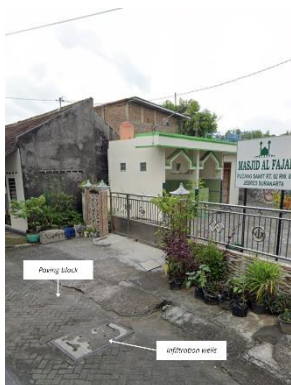
Gambar 5. Dokumentasi sumur resapan dan paving block pada badan jalan
