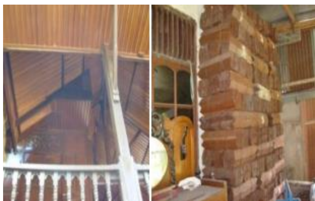
Gambar 9. Atap rumah tradisional Makassar yang terbuat dari material kayu
