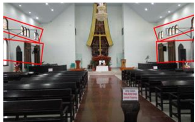
Gambar 9. Celah muai pada pintu, jendela, dan pemasangan kaca patri menjadi potensi kebocoran suara
